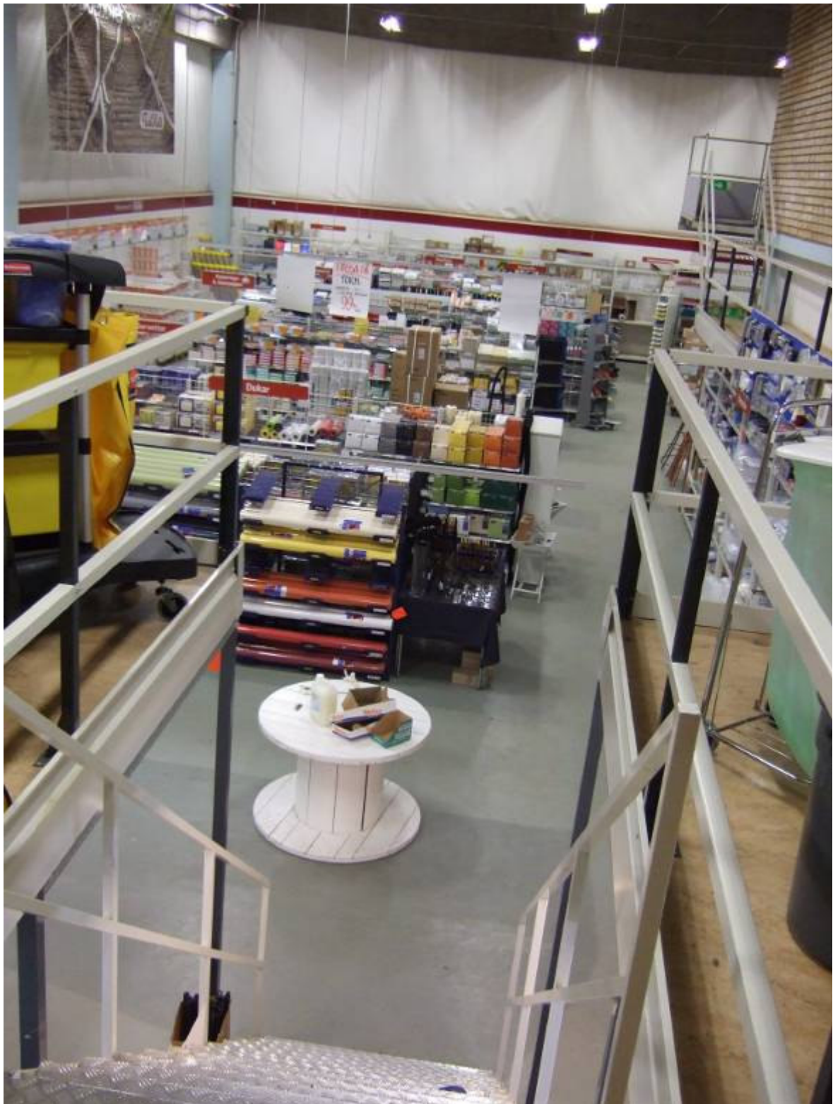
På trapetsplåten monteras 22 mm golvspånskivor, som försetts med en golvplastmatta. Räckan enl. S90-systemets standard. Specialtrappa med större bredd för att inbjuda kunderna att gå upp.
